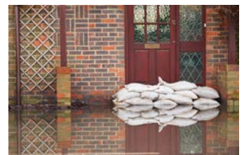
Bau- und Wasserschadentrocknung
